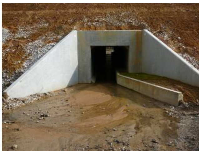
Photo 1 – Passage inférieur incluant un passage à sec (Photo F.Jussyk)
